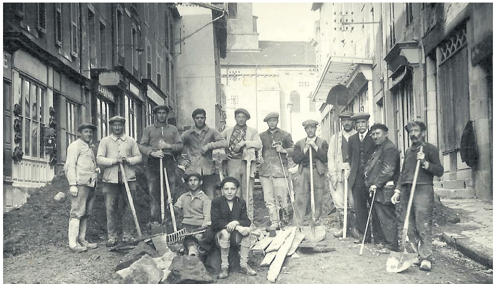
1932 : Travaux rue de la Liberté (rue Gabriel-Péri). Collection particulière, droits réservés.
